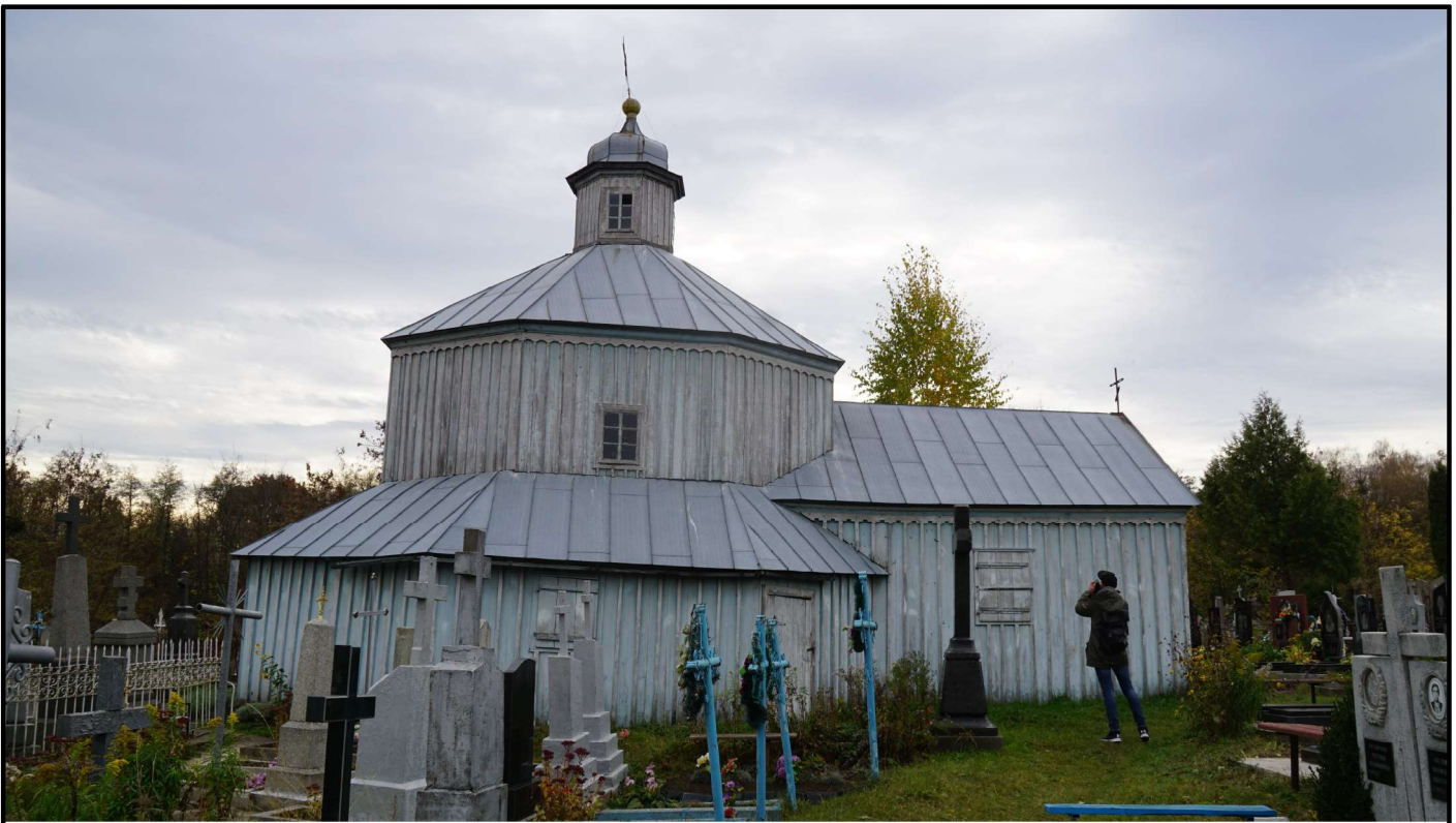
Фото 1. Острог. Каплиця на кладовищі. Загальний вигляд каплиці з півночі. 2018 р. Фото М.В.Наумця.
